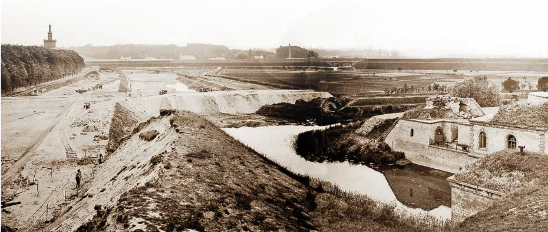
Abb. 45: Kaiser Wilhelm II. entschied 1904, dass die Nordwestfront des Rheingauwalls vom Rhein bis zum Mombacher Tor aufgelassen werden soll. Betroffen hiervon war auch das Rheinfort, das dem Hauptwall zur Flankierung vorgelagert war. Das Foto zeigt die großen Flächen und die aufwändigen Arbeiten, die mit der Einebnung des Rheingauwalls sowie des Rheinforts verbunden waren. Heute befindet sich auf dem Gelände des ehemaligen Rheinforts die Firma Schott.
